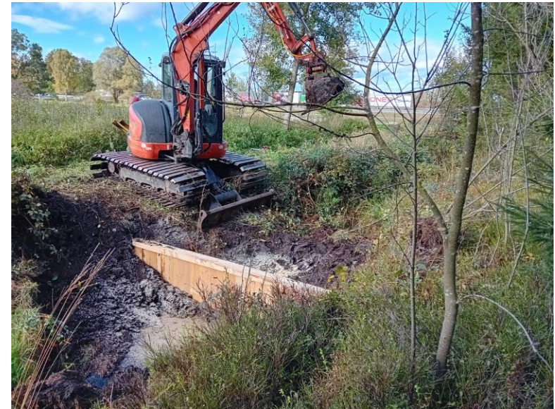
Bau eines Dammbauwerkes mit Holzspundwand
