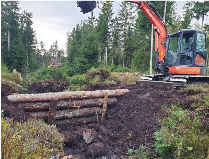
Bau eines stammholzarmierten Dammbauwerkes
