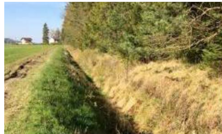
Aufnahme vorhandener Entwässerungsgräben
