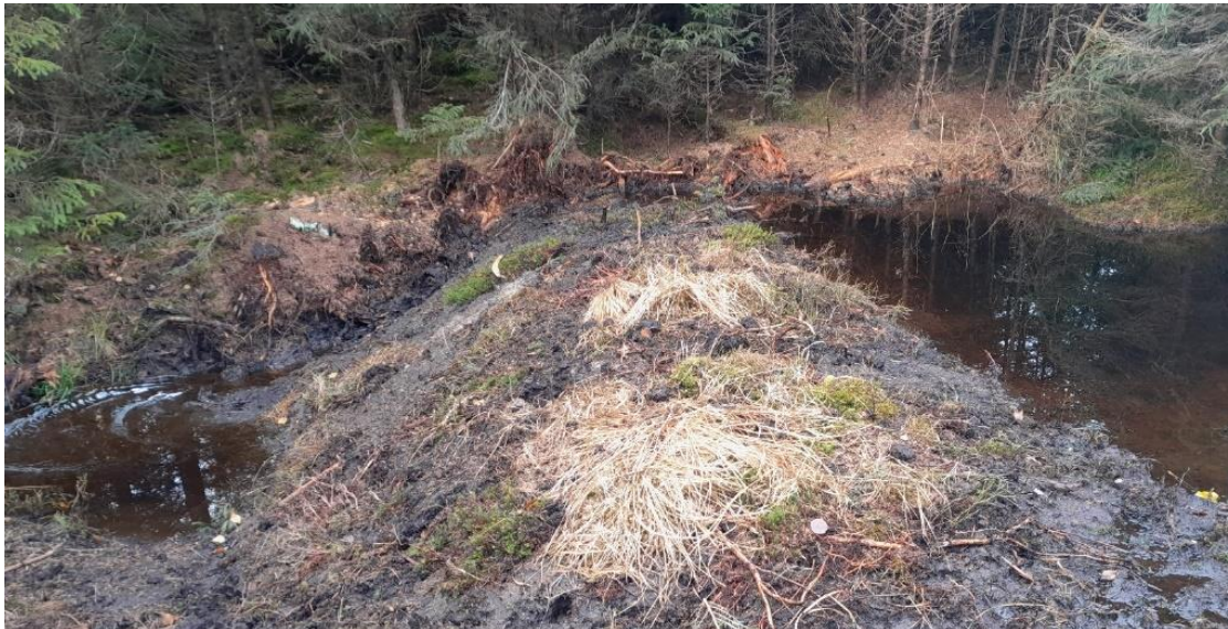
Überdeckung mit Torf und Pflanzensoden
