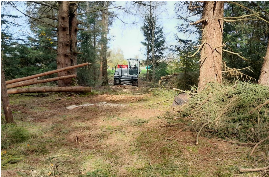
Freimachen einer Trasse für die Zuwegung
