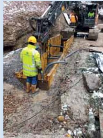
**Einbau der Verbauboxen bis zum tiefergelegenen Wasserstauer**
