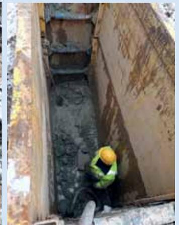
**Einbau der vertikalen Tonabdichtung auf den Stauer**
