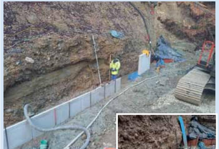
**Einbau der Betonfertigteilelemente zwischen Quellfassung und vertikaler Tonabdichtung**
