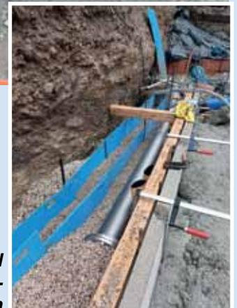
**Einbau des Edelstahl Filterrohres und der Quarz-Filterkiesschichten**
