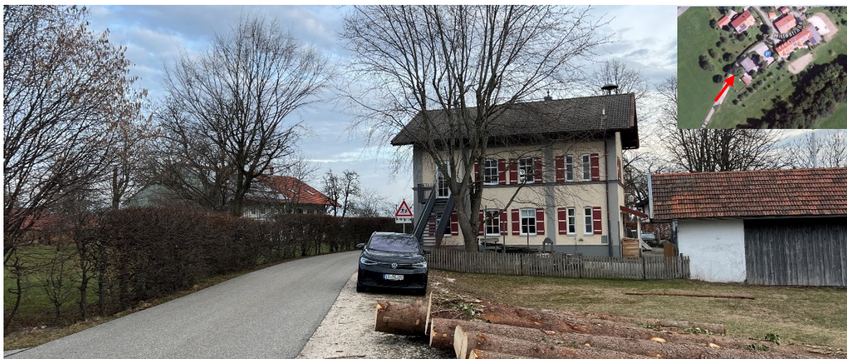
Abb. 14 Bestehende Ein- und Durchgrünung von Hittenkirchen
